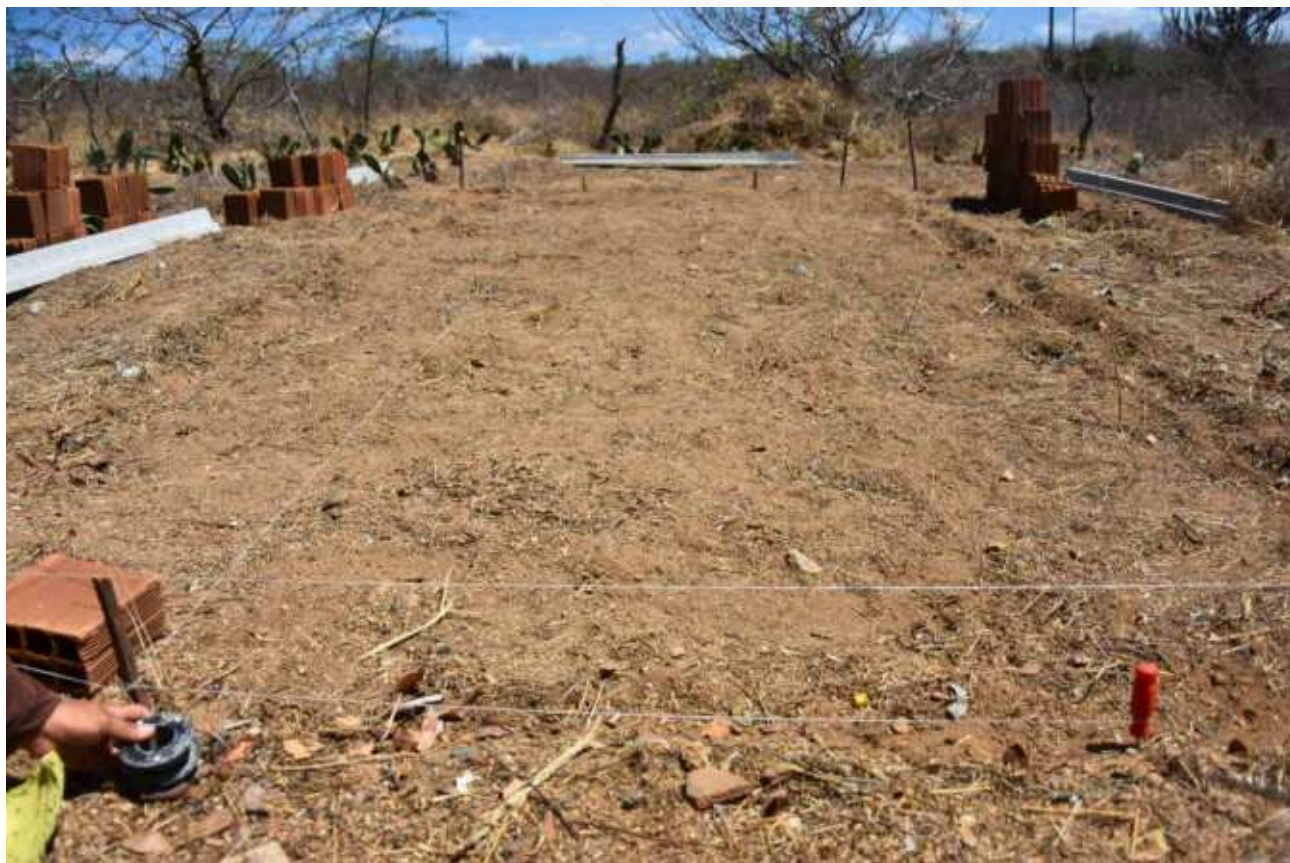
Figura 4 - Marcação do canteiro e área de proteção concluída
