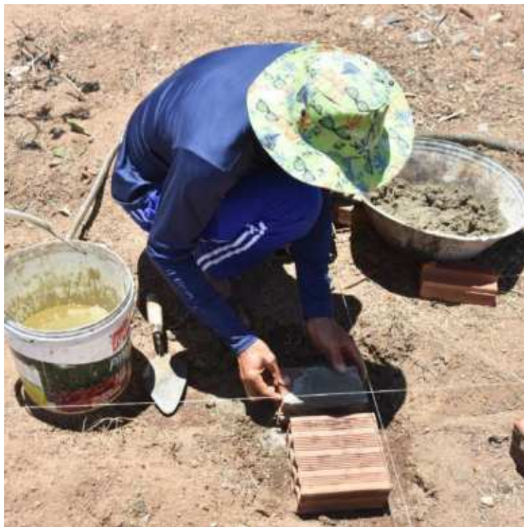
Figura 9 - Assentamento dos primeiros tijolos da base
