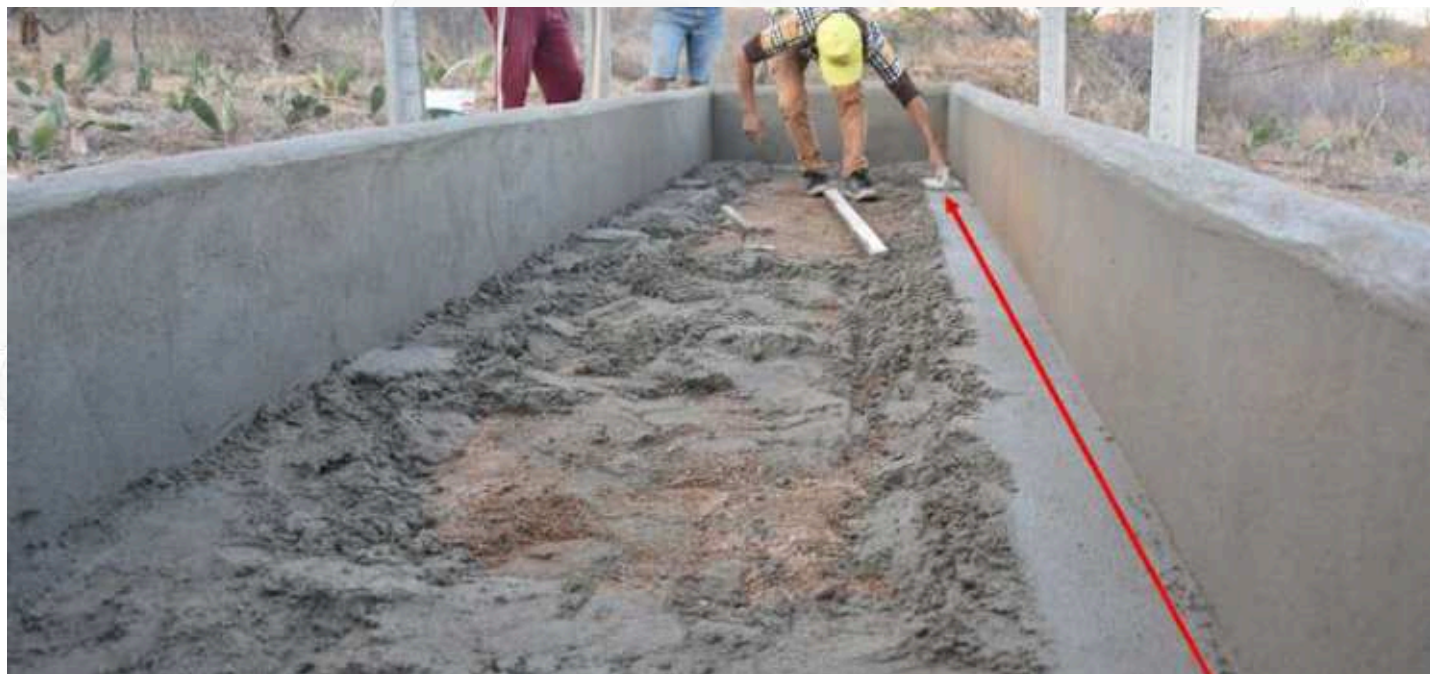
Figura 17 - Observe o piso sendo feito. A seta está indicando o caimento do piso para o local exato onde foi instalado o registro
