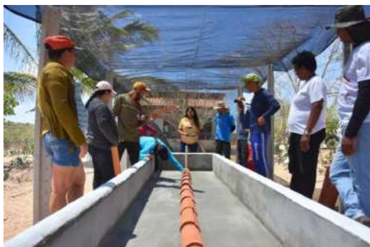
Figura 29 - Telhas sendo colocadas emborcadas sobre o cano de água.
