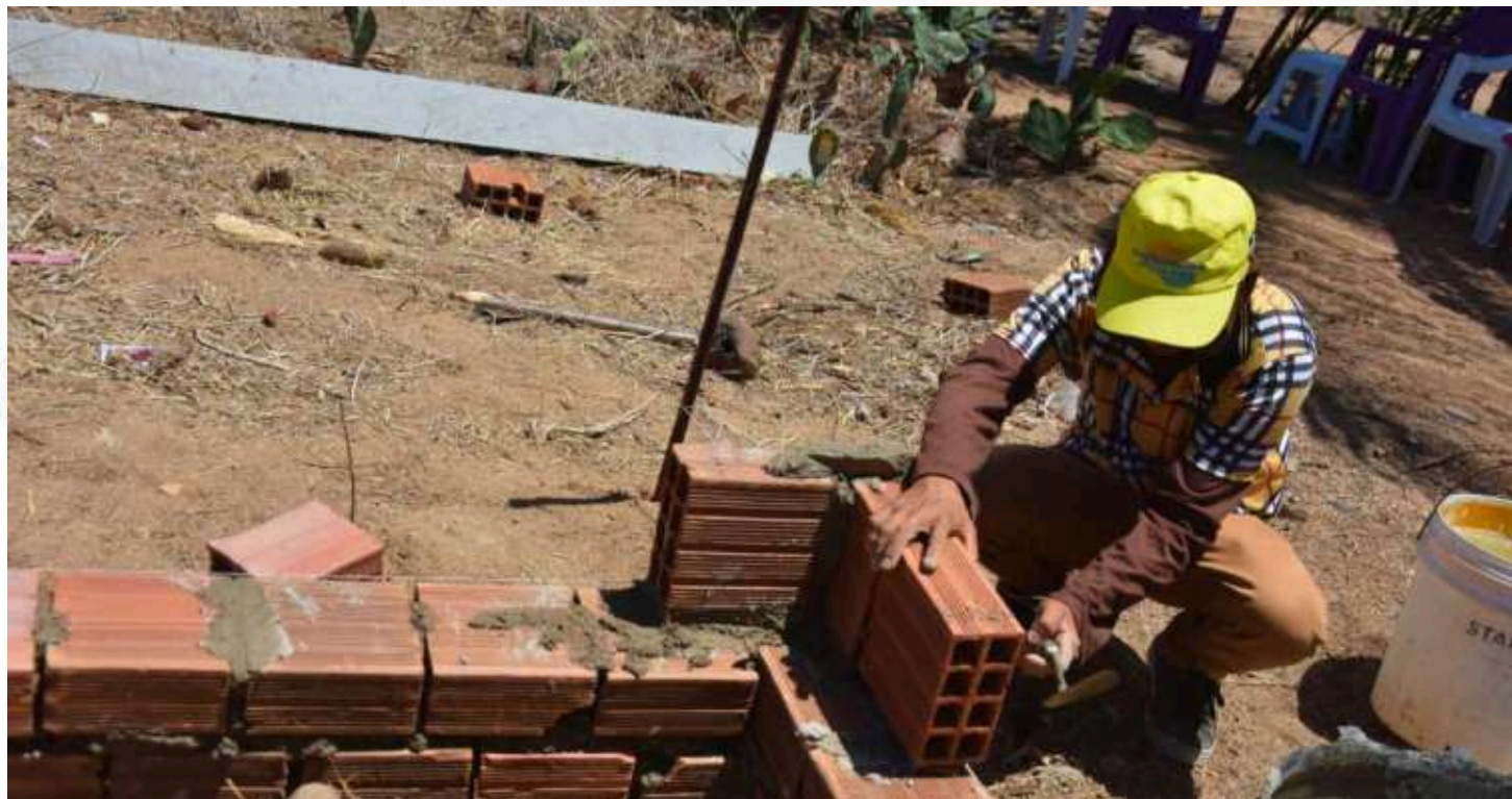
Figura 11- Levantamento das paredes do canteiro
