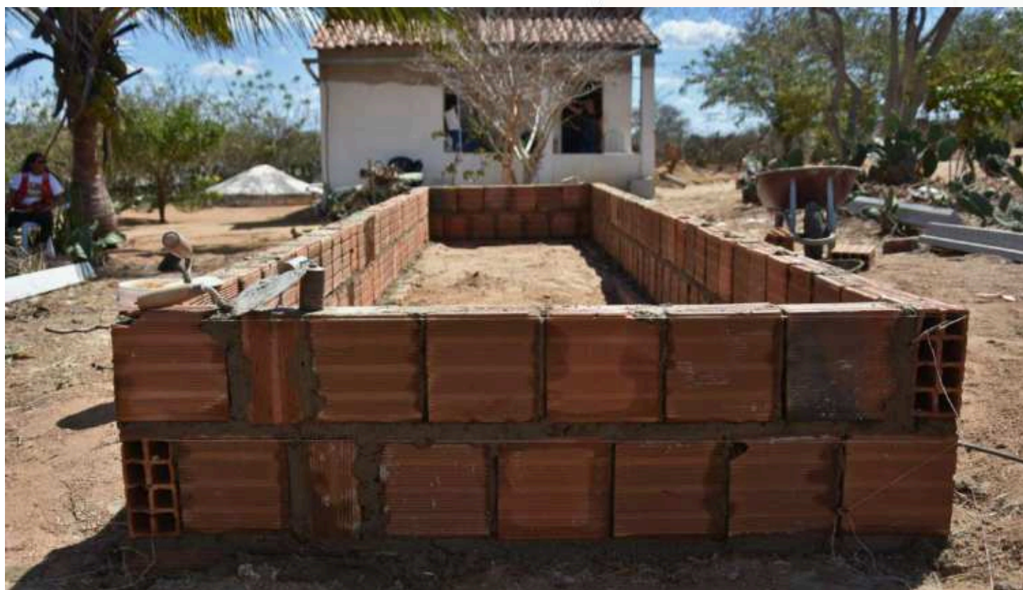
Figura 12 - Paredes do canteiro concluídas
