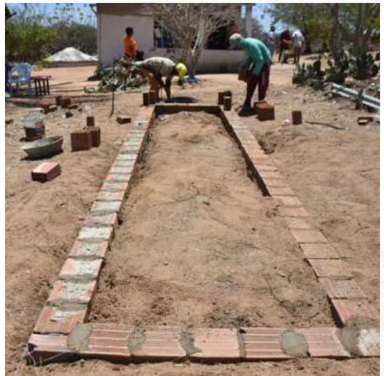
Figura 10 - Base do canteiro construída e nivelada
