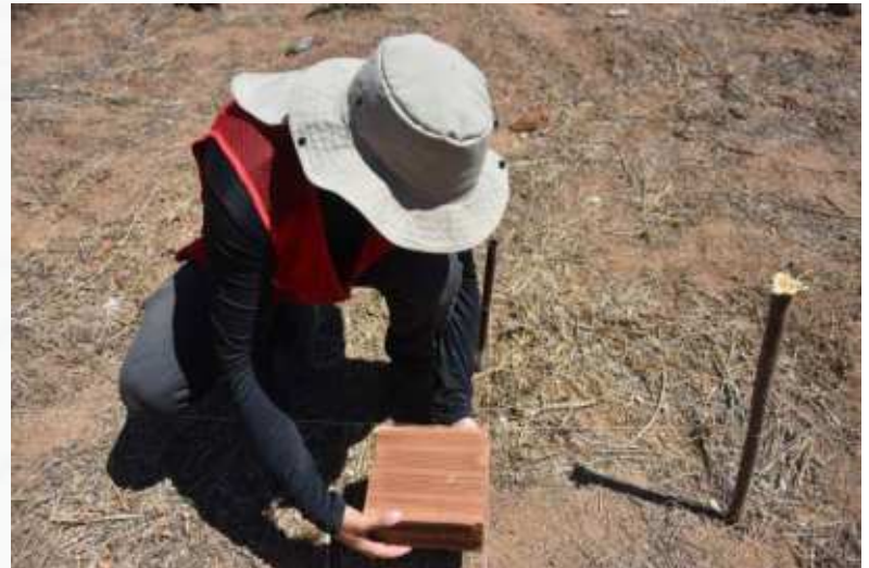
Figura 3 - Determinando o esquadro da obra
