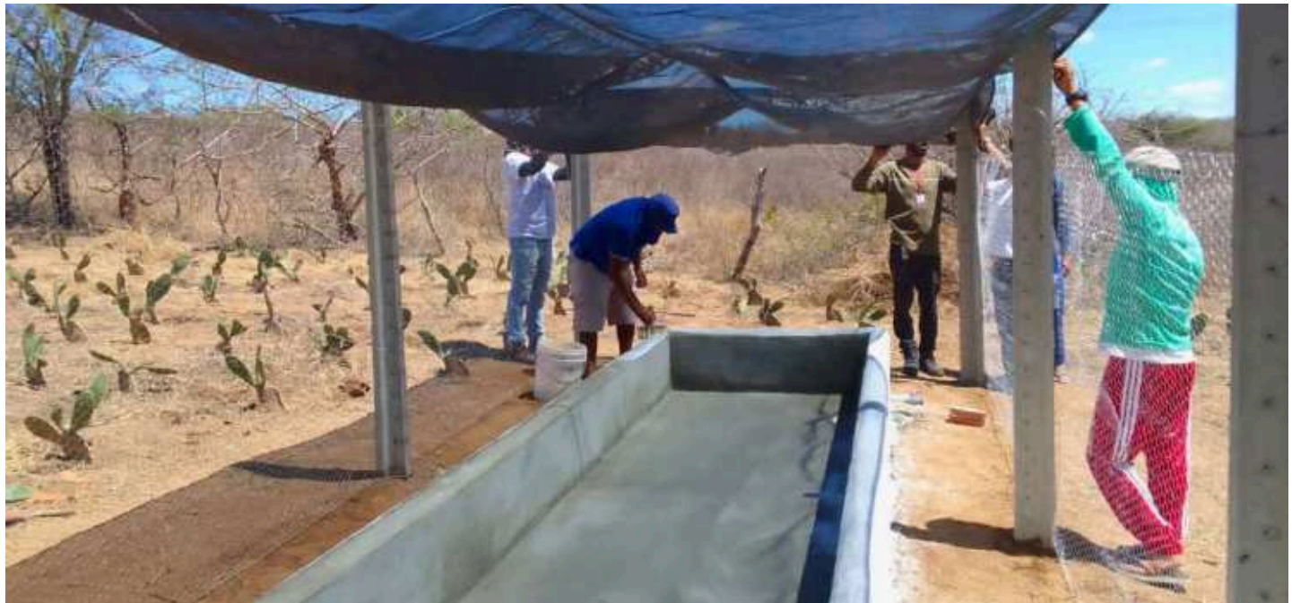
Figura 26 - Pintura do Canteiro
