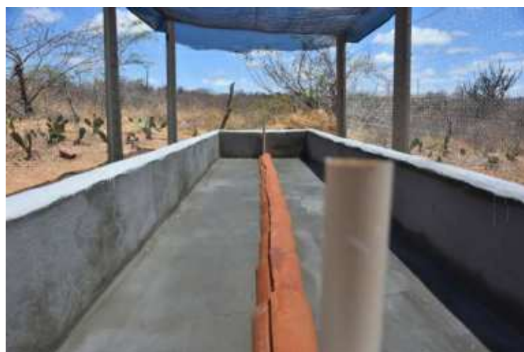
Figura 30 - Cano de água protegida com telhas
