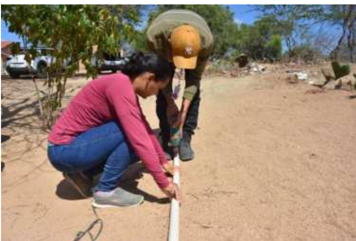
Figura 27 - Cano de águação sendo furado.
