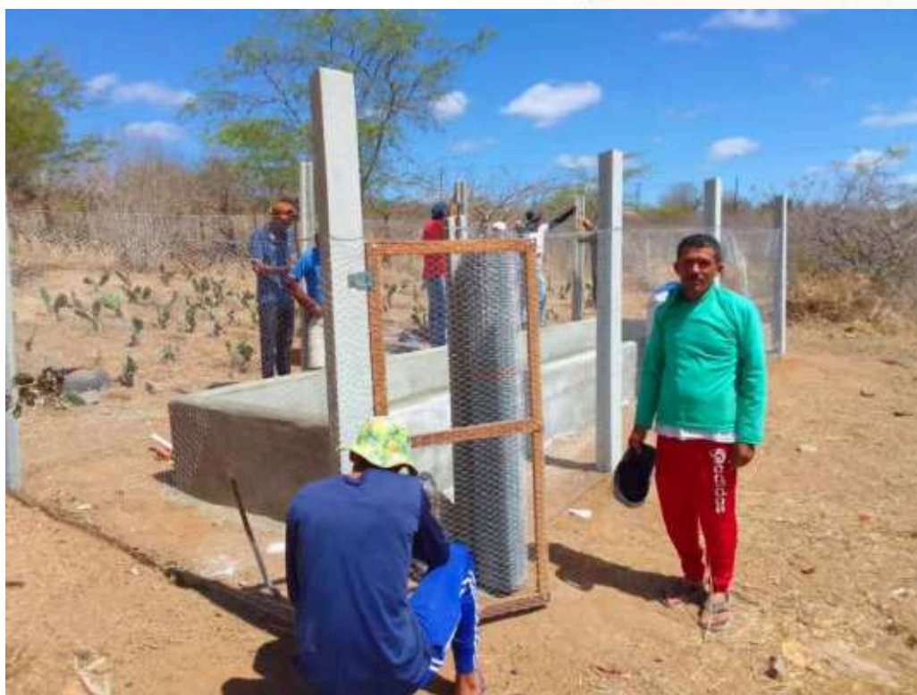
Figura 21 - Telamento do canteiro
