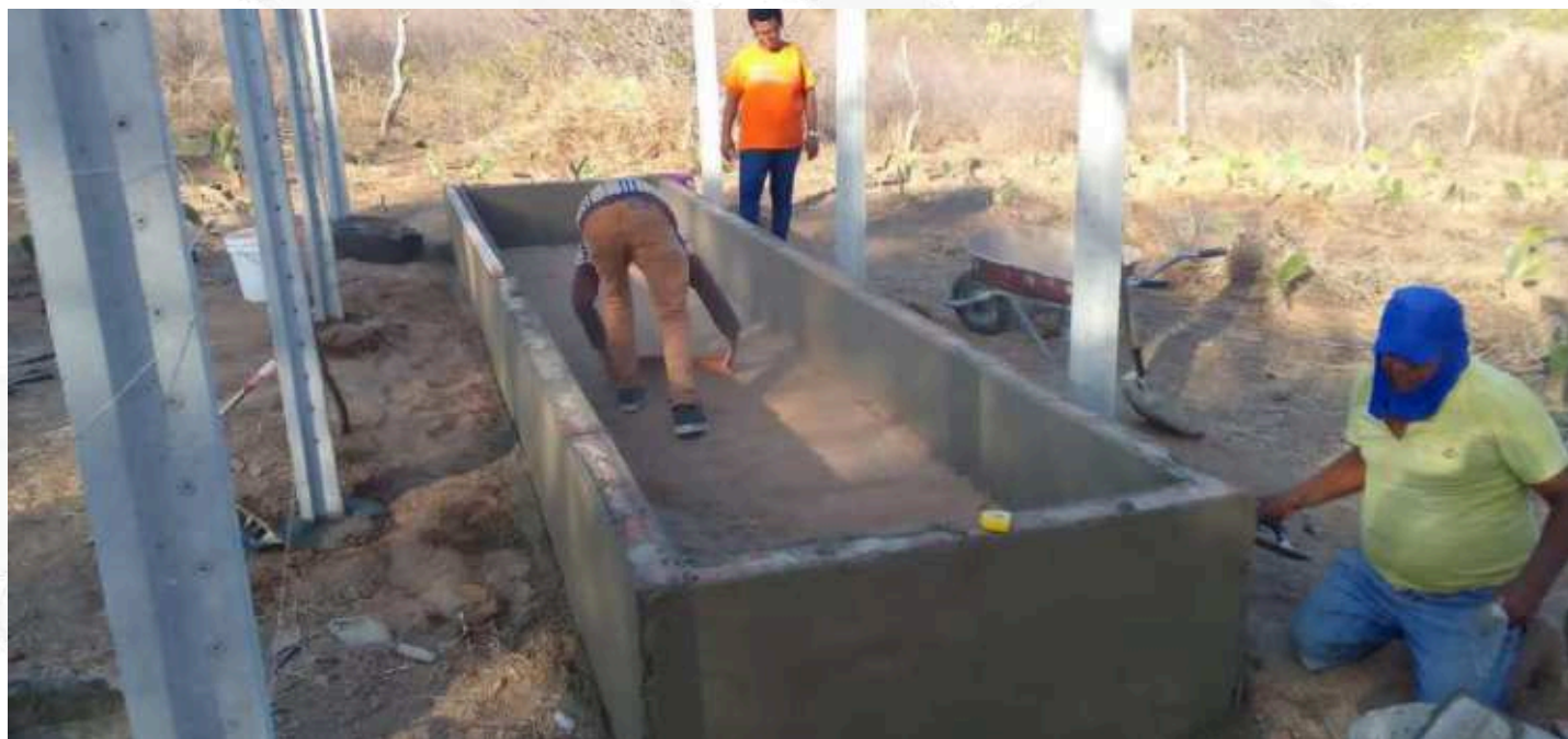
Figura 15 - Reboco pela parte de fora do canteiro sendo realizado
