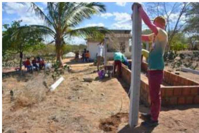
Figura 19 - Colocando as estacas do canto no mesmo nível.
