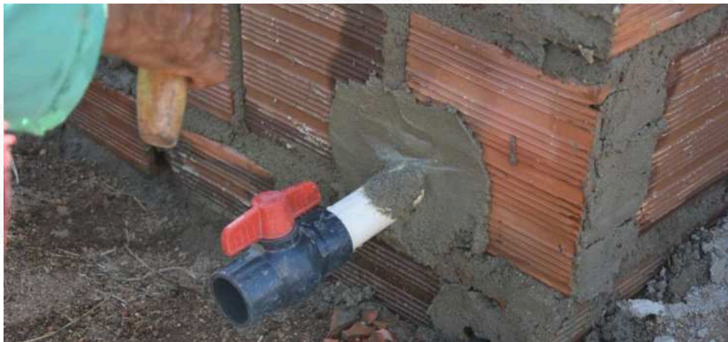
Figura 13 - Colocação do Registro de drenagem na altura do piso do canteiro
