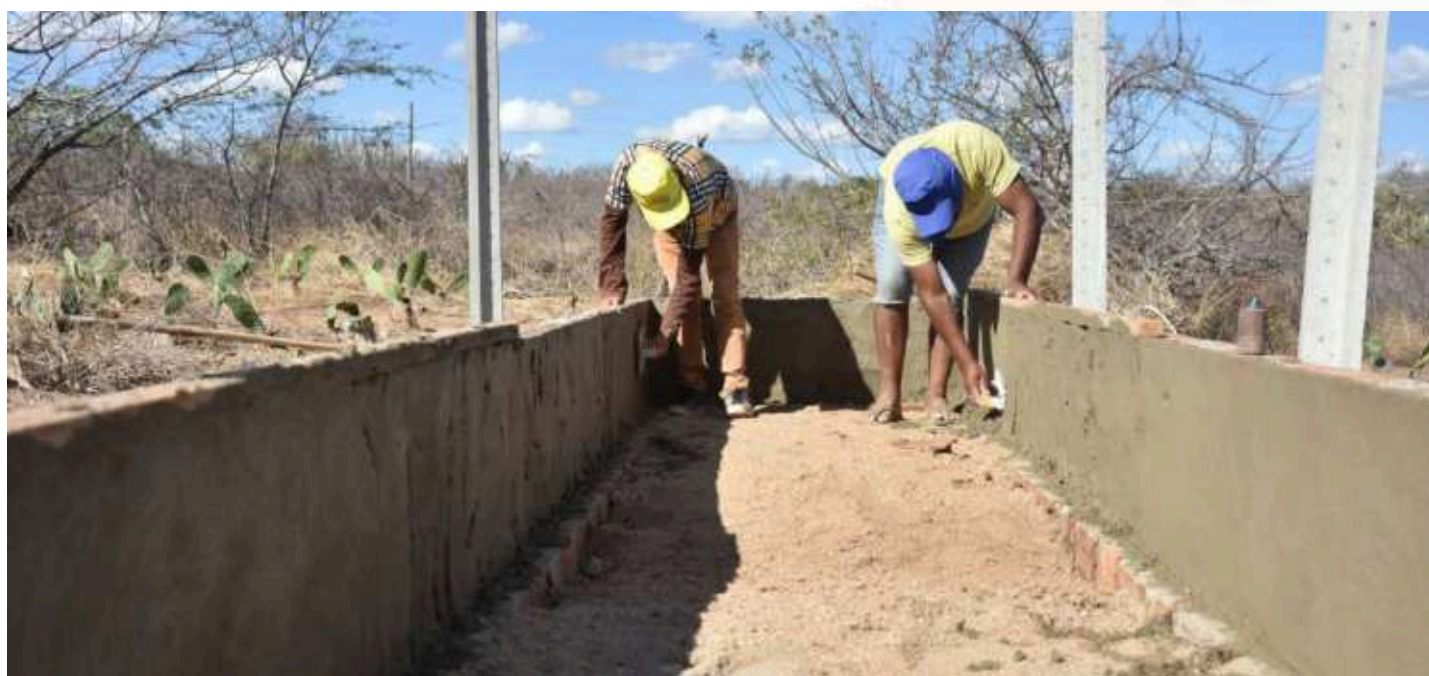
Figura 14 - Reboco pela parte de dentro do canteiro sendo realizado
