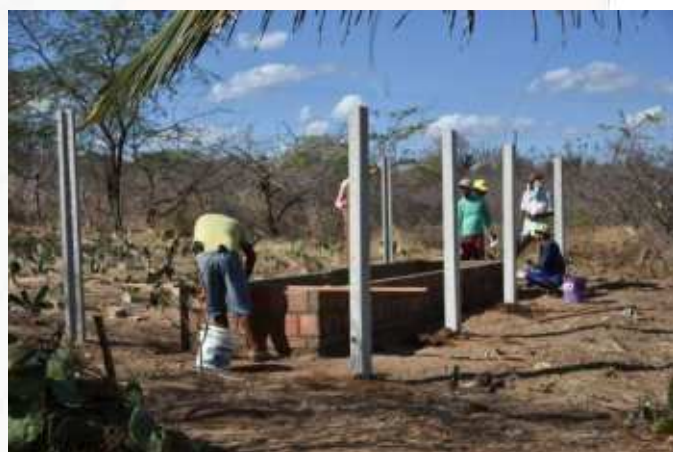
Figura 20 - Colocação das demais estacas sendo realizada.
