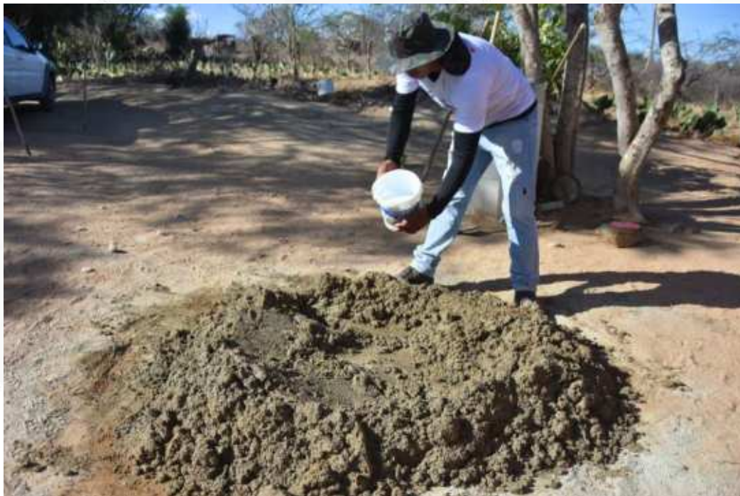
Figura 8 - Traço de massa pronto para ser usado
