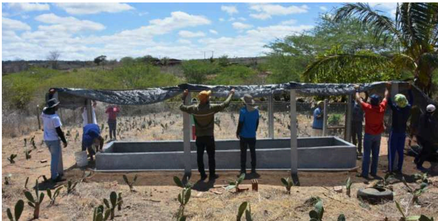
Figura 25 - Tela sombrite sendo colocada
