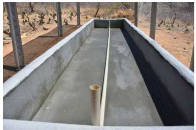
Figura 28 - Cano de águação colocado sobre o piso do canteiro.
