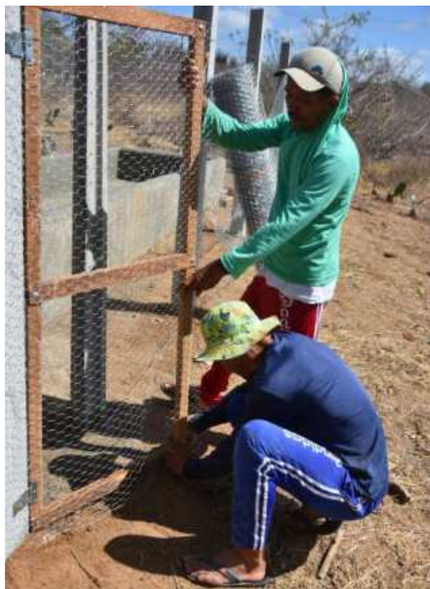
Figura 23 - fixação do portão de acesso
