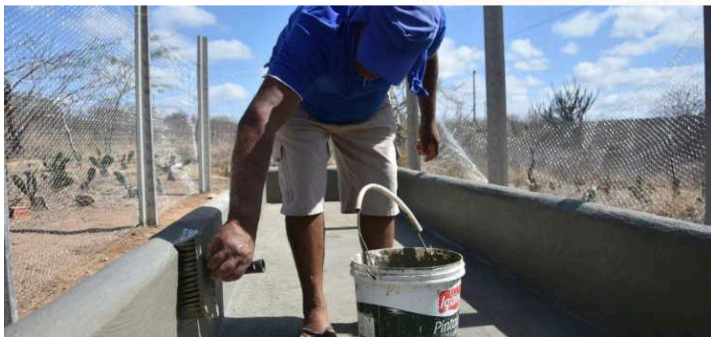
Figura 18 - Golda de cimento sendo passada na parte de dentro do canteiro.
