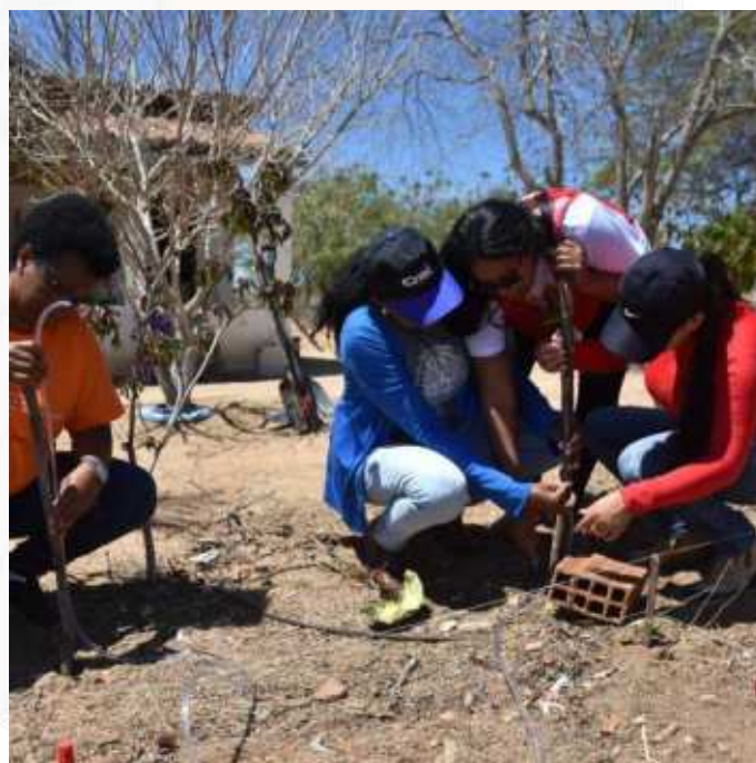
Figura 6 - Determinando o nível do terreno no sentido da largura do canteiro
