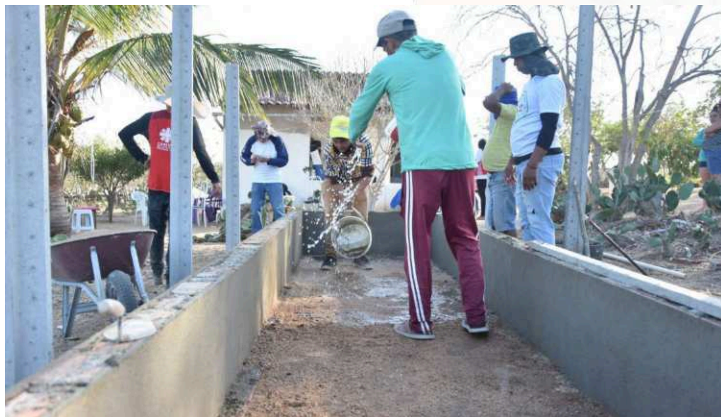
Figura 16 - Preparo da área antes de iniciar a construção do piso
