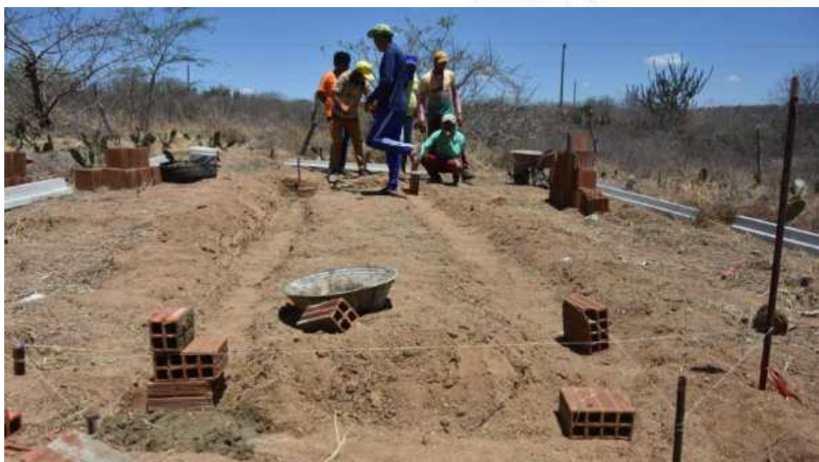
Figura 7- Escavação da área da base concluída
