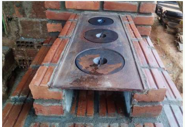
Figura 20 - Detalhe do corte nos tijolos da última fileira da câmara de combustão para encaixe da chapa mineira com três bocas
