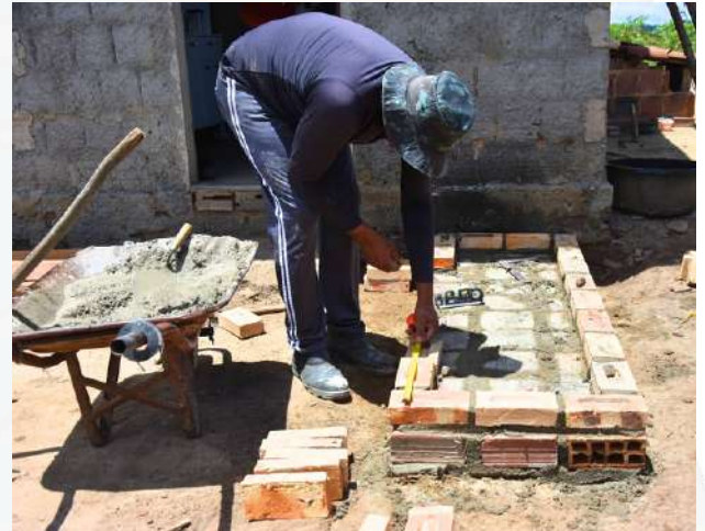
Figura 11 - Parede da bancada do fogão ecológico sendo levantada
