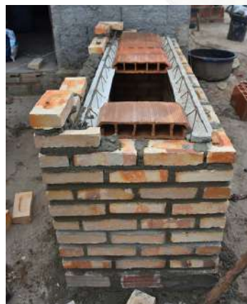
Figura 14 - Detalhe da posição das nervuras treliçadas e das lajotas de cerâmicas sobre a base do fogão
