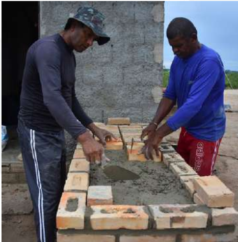
Figura 16 - Detalhe do preenchimento da laje com concreto e o assentamento do tijolo sobre o concreto ainda mole
