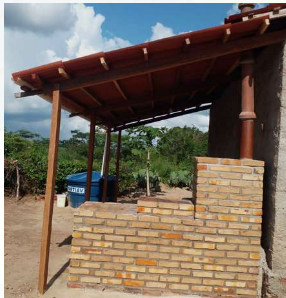
Figura 28 e 29 - Construção da cobertura de proteção do fogão
