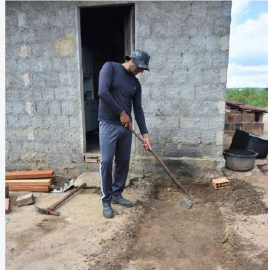
Figura 7 - Nivelando o terreno
