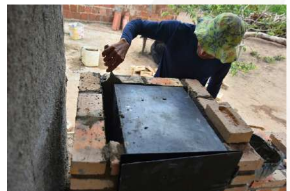
Figura 24 - Detalhe da aplicação da argamassa refratária na área interna da caixa e vedação do forno na parede frontal.
