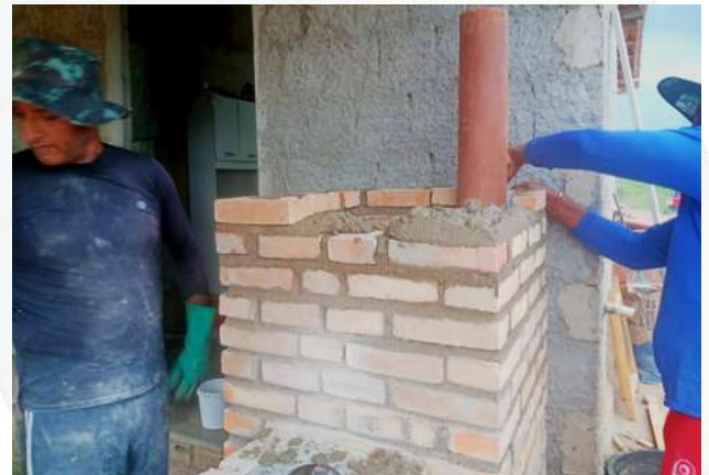
Figura 26 - Detalhe do fechamento da caixa do forno e o posicionamento e fixação da chaminé.
