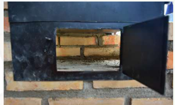
Figura 23 - Detalhe da porta do cinzeiro alinhada à bancada, com a parede de 15 centímetros na parte traseira da caixa, servindo de suporte para o forno
