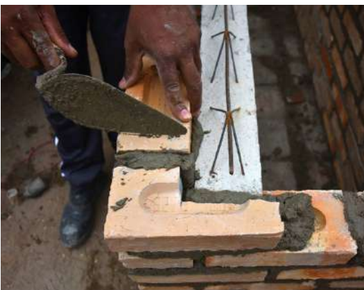
Figura 13 - Detalhe do corte do tijolo e encaixe da nervura treliçada na parte interna da parede para ficar oculta
