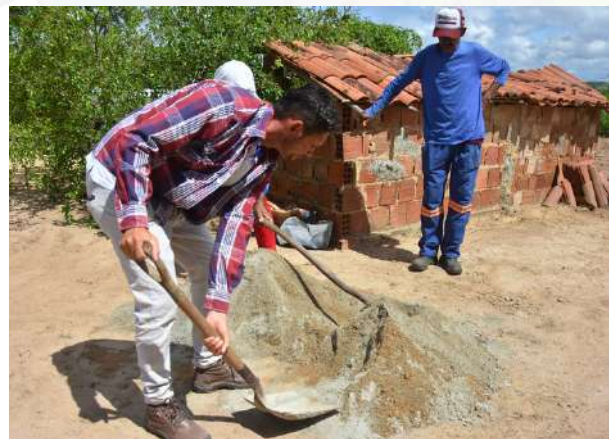
Figura 8 - Traço de massa sendo preparado para construção do fogão ecológico
