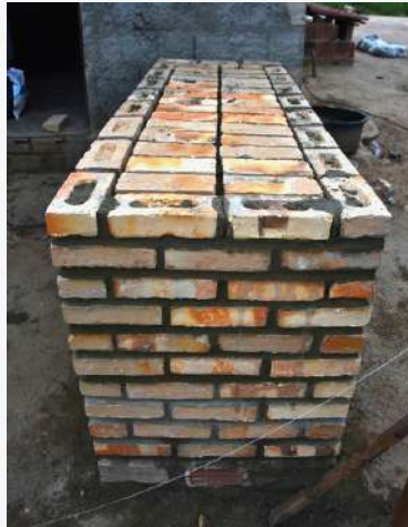
Figura 17 - ocultação da laje de concreto com os tijolos maciços
