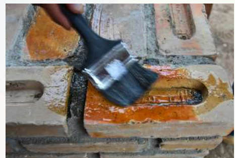
Figura 30 e 31 - aplicação da resina
