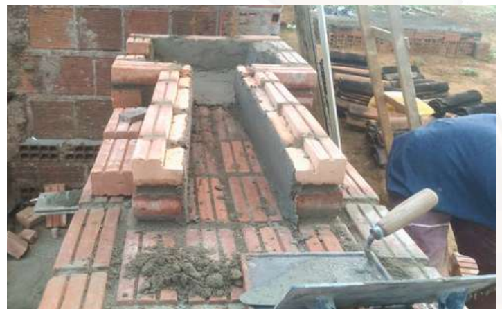
Figura 19 - Câmara de combustão e caixa do forno em processo de construção
