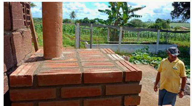
Figura 27 - Detalhe da caixa do forno finalizada
