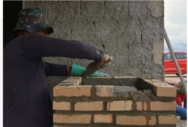
Figura 25 - Indicação do ponto em que as paredes da caixa do forno ultrapassam 8 cm de altura, sinalizando o momento adequado para o fechamento da caixa.
