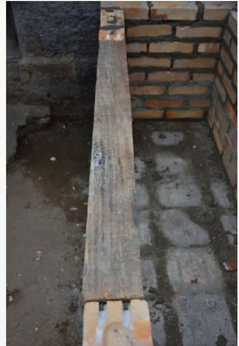
Figura 12 - Detalhe da colocação do suporte móvel de madeira para o assentamento dos tijolos na abertura destinada ao armazenamento de lenha
