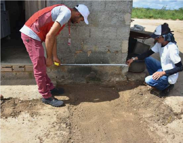
Figura 6 - Verificando as medidas do local para construção da base
