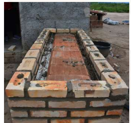
Figura 15 - Assentamento de mais duas fileiras de tijolos para ocultar a laje
