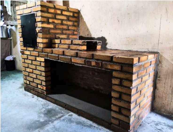
Figura 3 - Fogão Ecológico concluído
