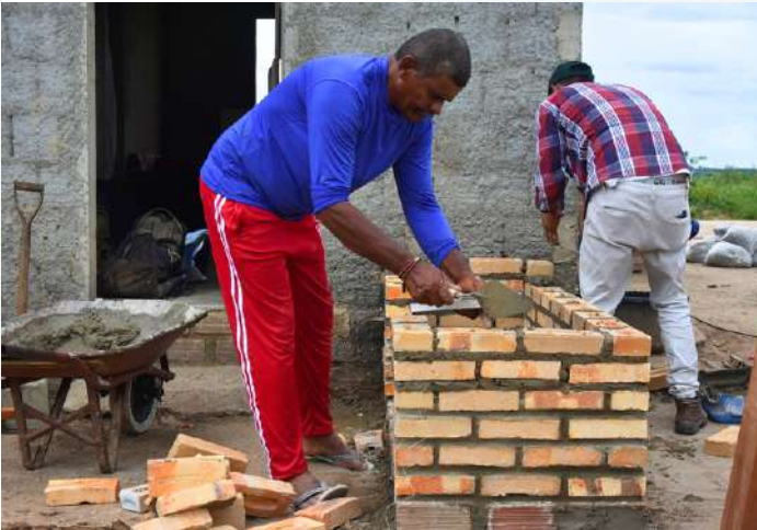
Figura 10 - Construção da bancada do fogão ecológico utilizando tijolos maciços
