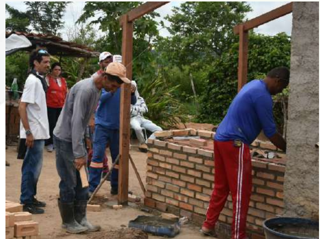
Figuras 1 e 2 - Trabalho coletivo para construção do Fogão Ecológico
